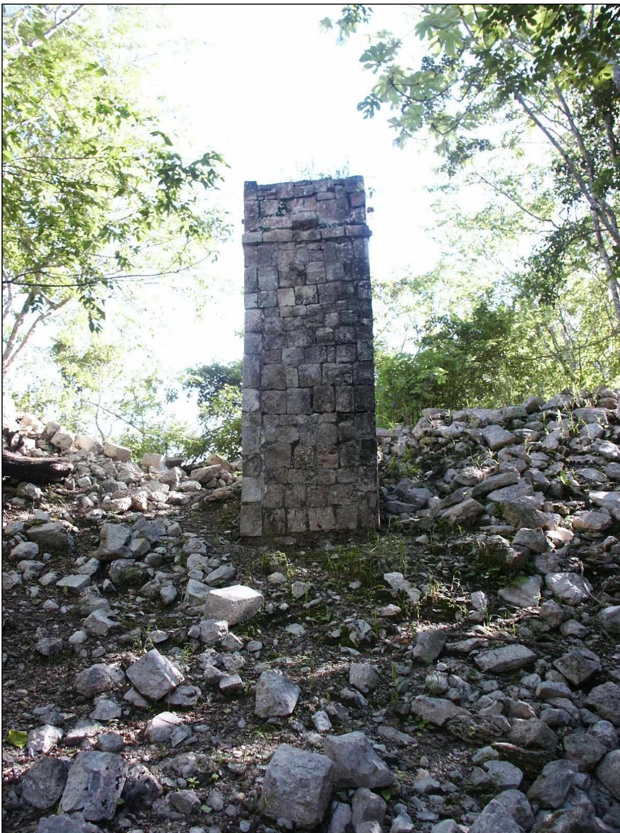
Figura 4 Estructura VI antes de la intervención
