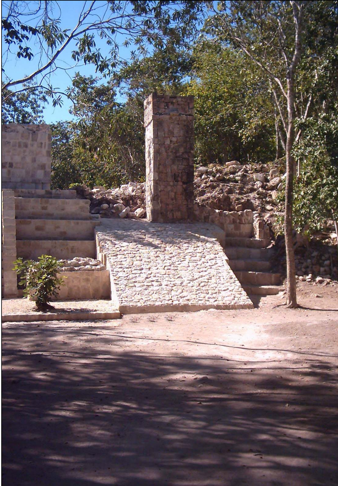
Figura 5 Estructura VI después de la intervención
