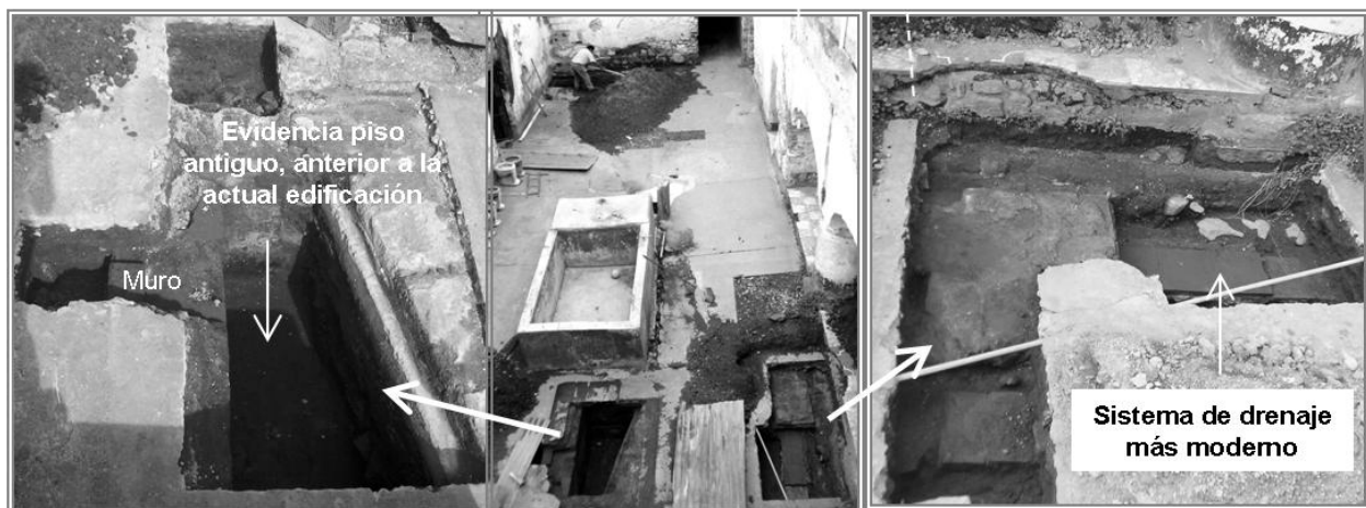
Figura 6 Evidencias de muros y niveles de piso más antiguos a esta construcción
