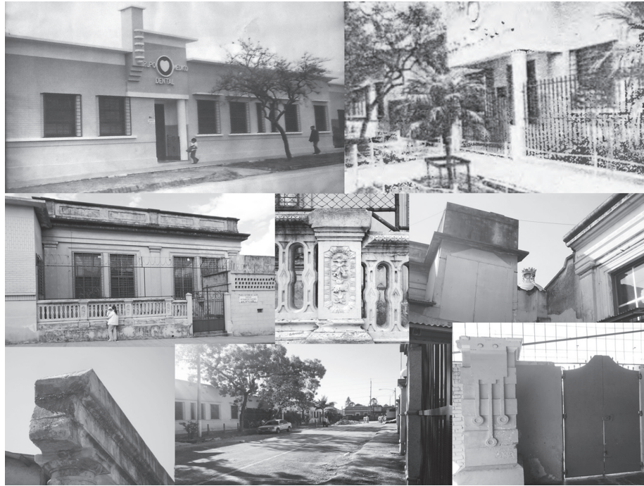
Fig.5: Fotos del edificio de la Sociedad Protectora del Niño en la segunda mitad del siglo XX y Enero 2014 (Fotos: SPN, R. Larios e Y. Putzeys).
