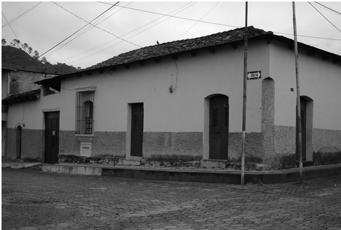
Fig.10: Detalle de la arquitectura vernácula de Quezaltepeque. En ella destacan los conceptos en la utilización de materiales como: la madera para las puertas, el barro para la teja, la tierra para el adobe y las piedras para los cimientos. Mucha de esta arquitectura está desapareciendo. Fuente: J. Cáceres, 2013.
