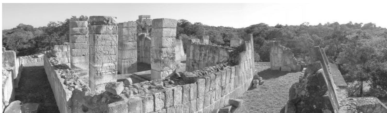
Figura 2 Aspecto actual del santuario de 3C1, desde la esquina suroeste.
