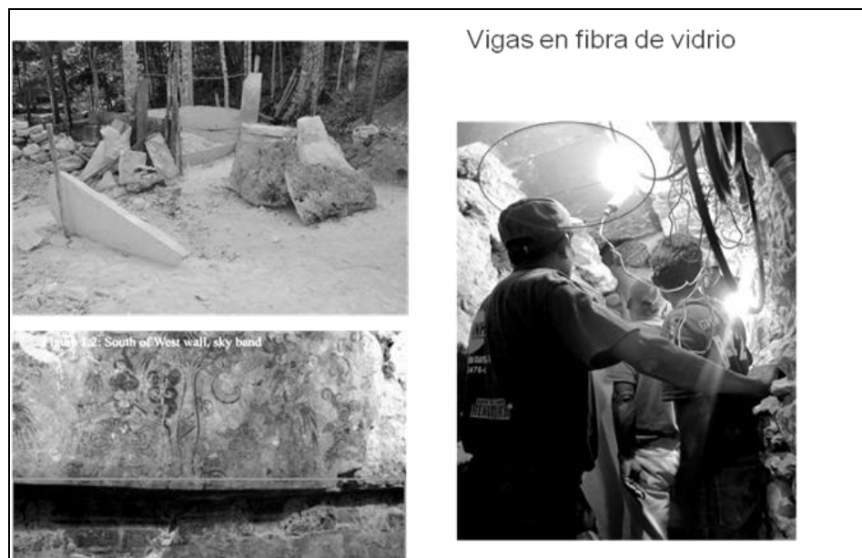
Figura 3 Trabajos de conservación y estabilización del cuarto de las pinturas.
