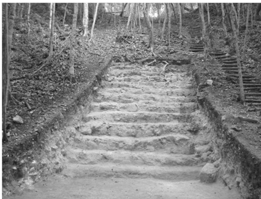
Figura 5 Escalinata de acceso al primer basamento de la Acrópolis La Pava.
