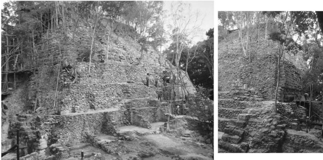
Figura 6 Trabajos de consolidación en la Fachada oeste del complejo La Danta.
