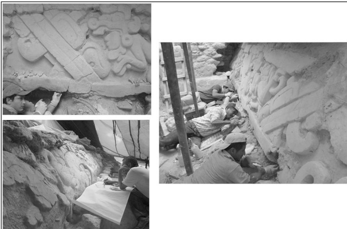
Figura 14 Trabajos de consolidación de paneles de estuco en la Gran Acrópolis Central.
