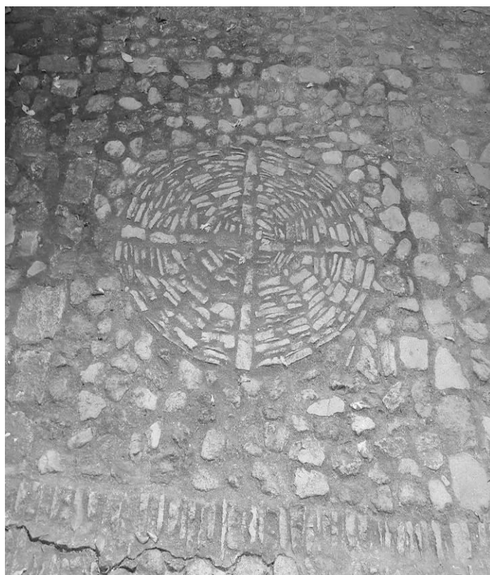
Figura 8 Empedrado que utiliza la técnica mixta
