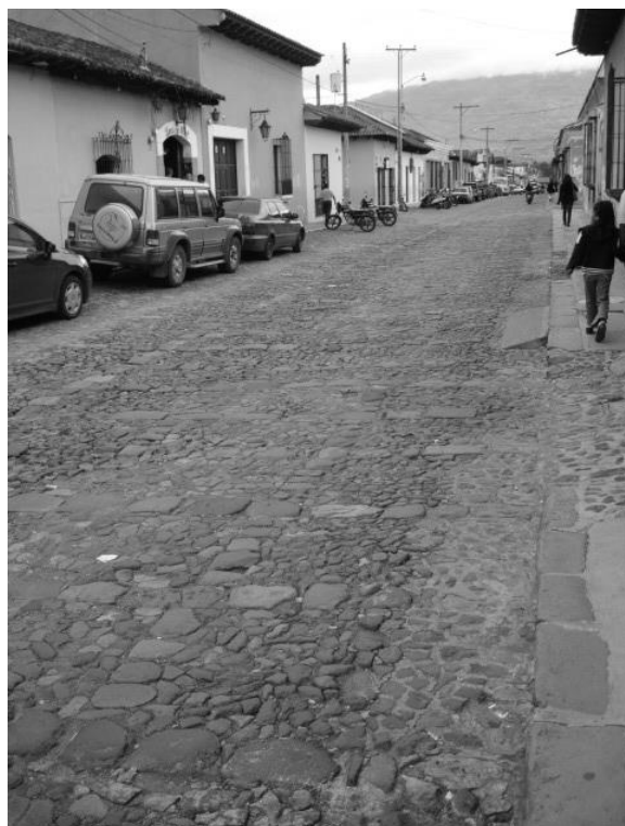
Figura 1 Empedrado rustico elaborado con piedra bola
