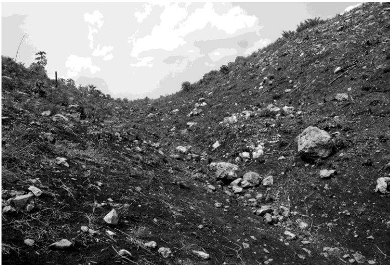
Figura 4. Muro de retención colapsado en el Arroyo de Gaspar (foto de M. Eberl).
