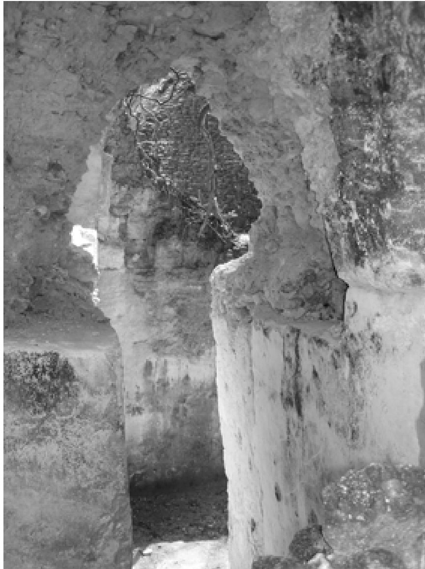
Figura 3 Evidencia (improntas circulares) de dinteles de palo tinto, en cámara del Edificio D
