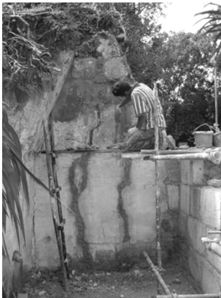
Figura 7 Consolidación de muros, Edificio Q
