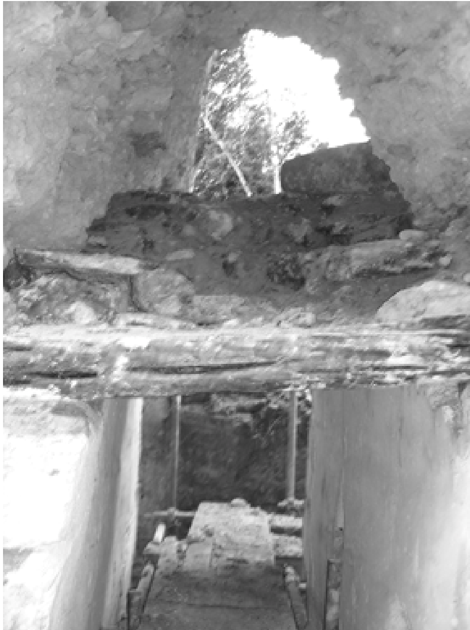
Figura 4 Integración de dinteles rollizos (palo tinto), en cámara del Edificio D
