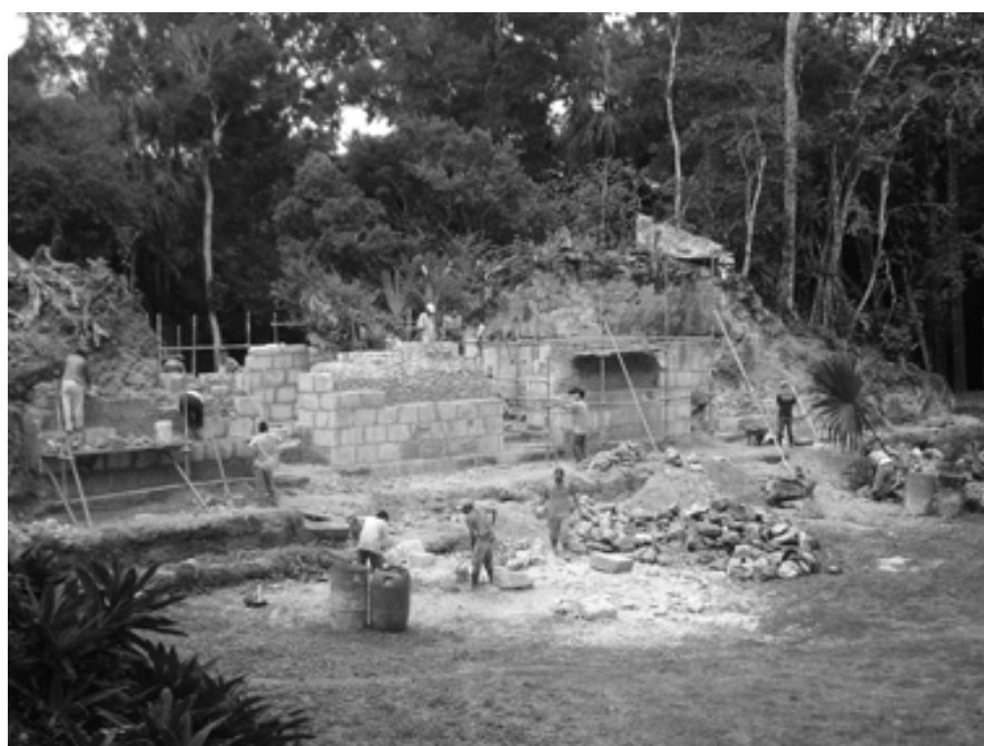
Figura 8 Restauración del sector poniente, Edificio Q
