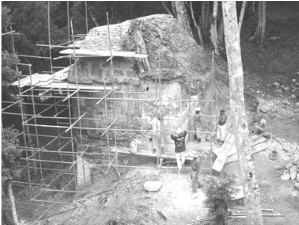
Figura 5 Integración de muro de fachada en esquinero suroriente del Edificio M
