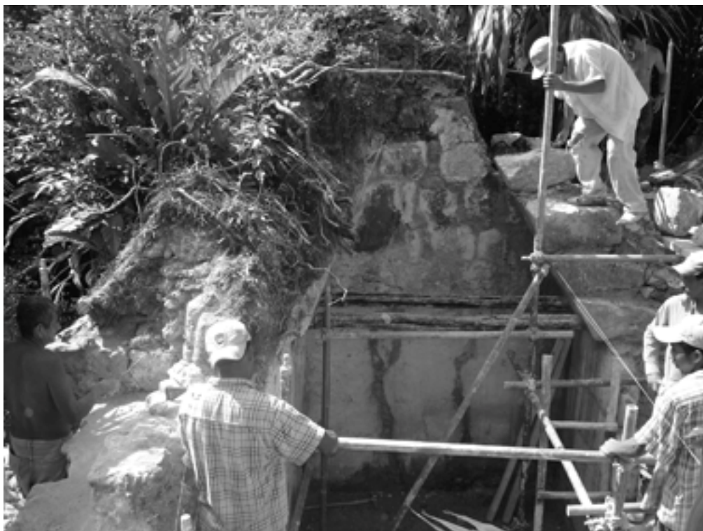
Figura 9 Integración de pasadores y reintegración de material en bóveda, Edificio Q
