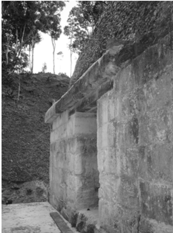
Figura 2 Integración de dinteles de chicozapote y cornisa en Edificio G
