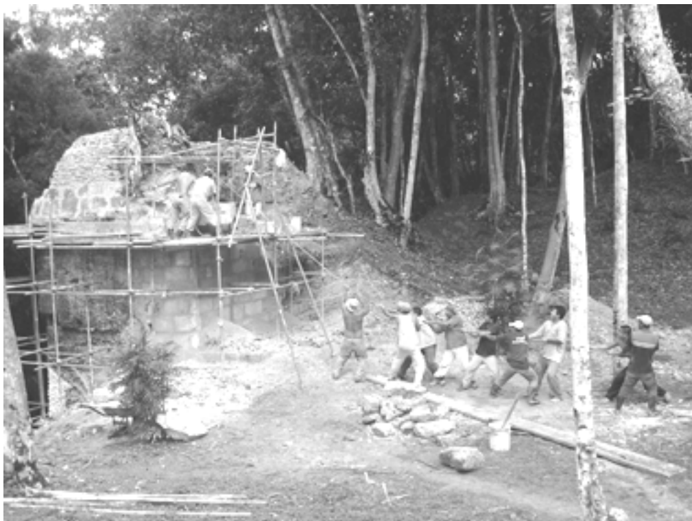
Figura 6 Integración de esquinero suroriente del Edificio M
