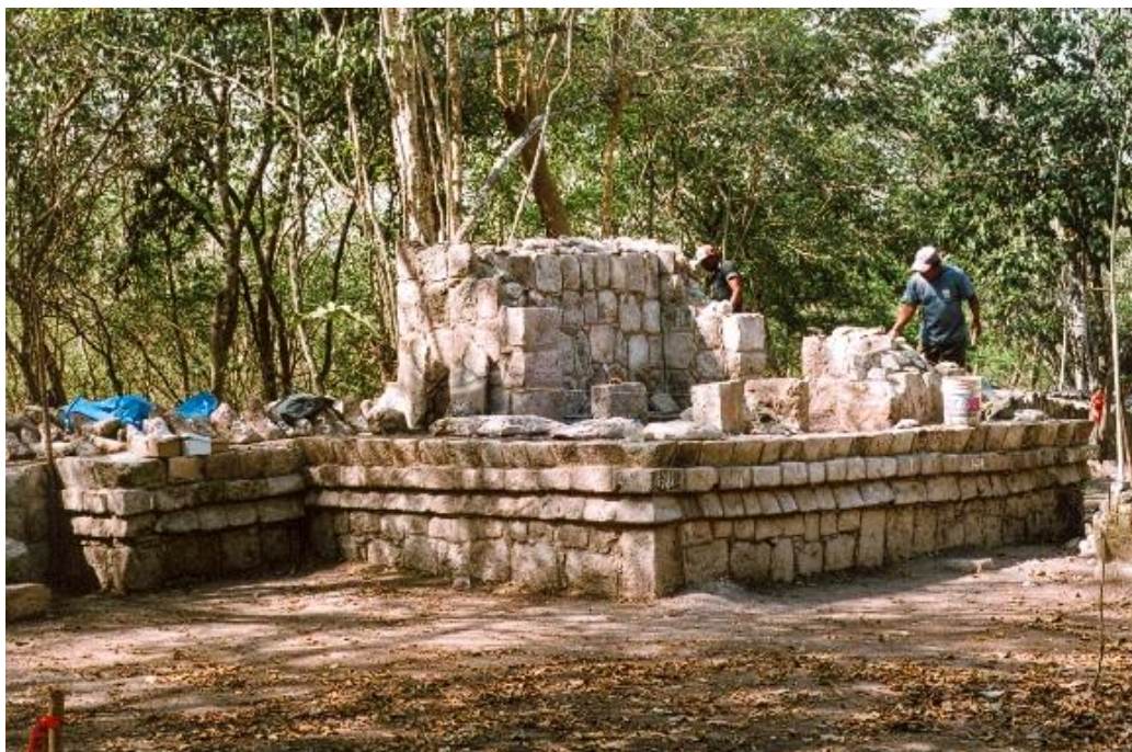
Figura 6 Estructura No 5C12 poco antes de terminar la consolidación
