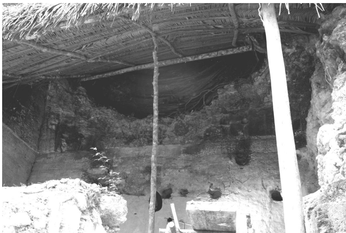
Figura 4 Restos de la bóveda de la estancia principal del Palacio 6J1
