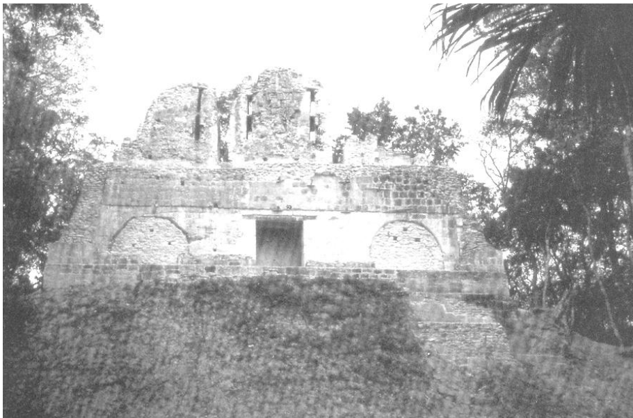
Figura 2 Fotografía tomada por W. Wurster, donde se observan las columnas arqueostereográficas muy erosionadas con la sección mutilada
