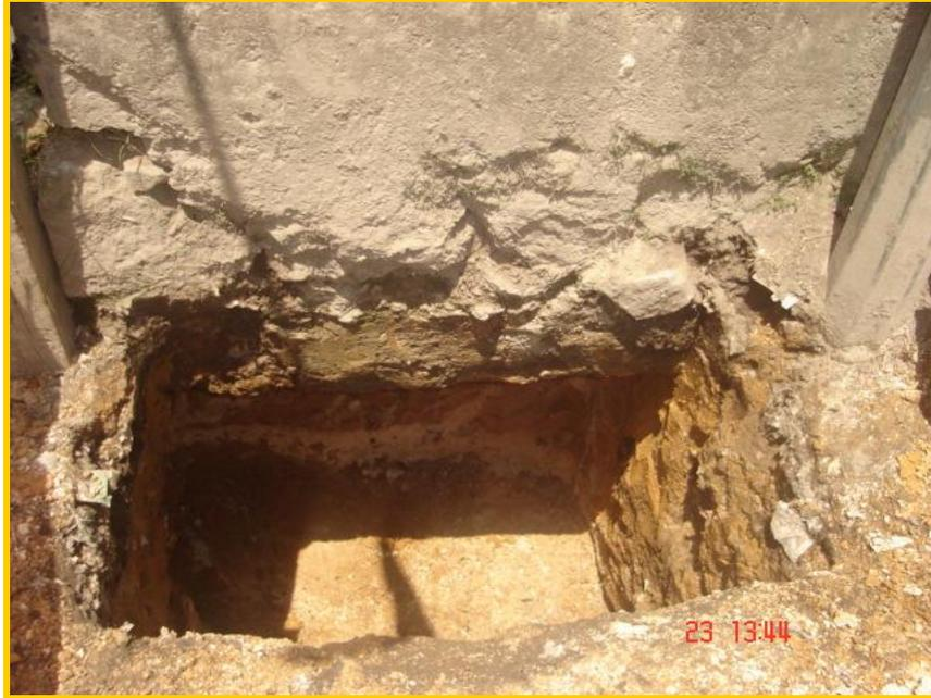
Figura 6 Excavaciones perimetrales, definición de cimientos
