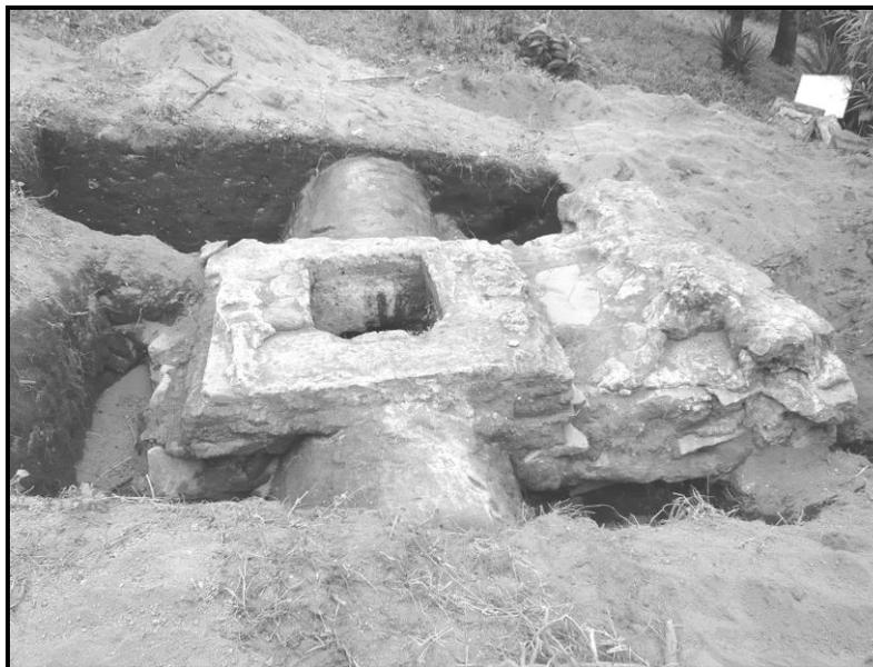
Figura 2 Detalle de la caja de registro y el paso de acueducto de Esta a Oeste, además de observar el adosamiento de la Caída de Agua (columnaria) a la derecha de la imagen.
