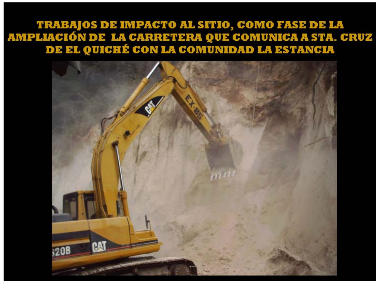
Figura 7 Ampliación de la carretera
